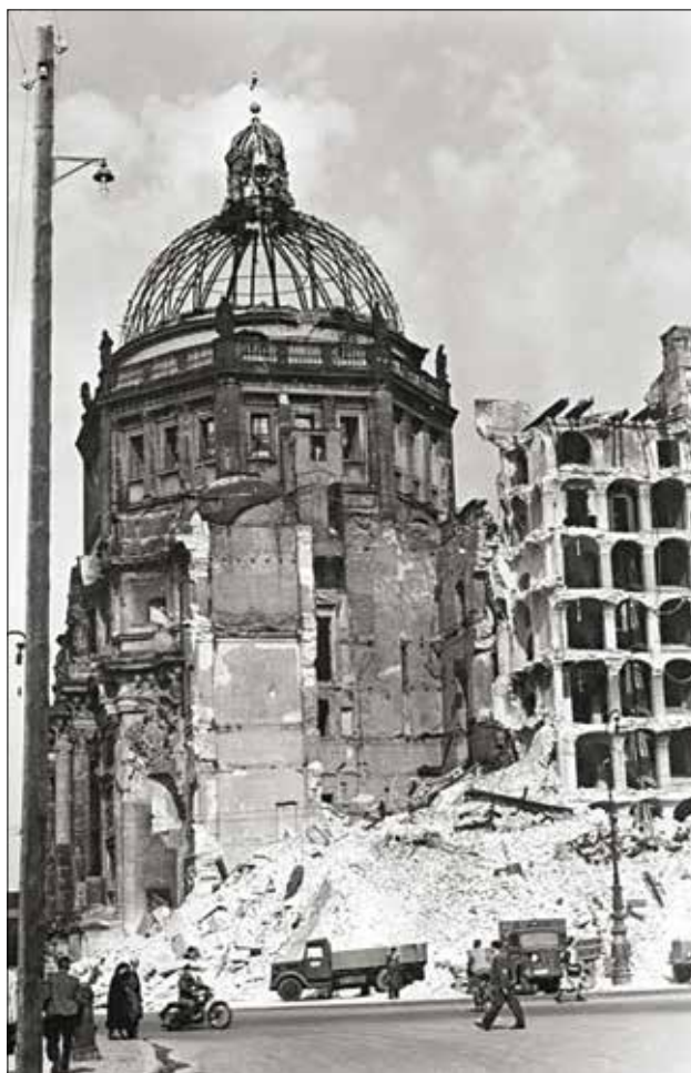
Berlínsky palác poškodený spojeneckým bombardovaním na konci druhej svetovej vojny
